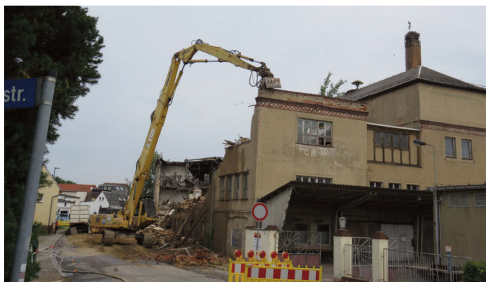
Abriss der Fabrik im Juni 2020
